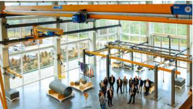
Nosturijärjestelmät sijaitsevat kolmessa kerroksessa ja odottavat vierailijoita testaamaan erilaisia nostureita.
